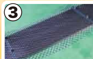
③ 最後に雨といの長さ以外はネット部分を裁断し完成。
