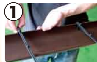
① 取付けたい雨といに、約40~50cm間隔で「取付け専用パーツ」を、雨といの淵に取付けます。
